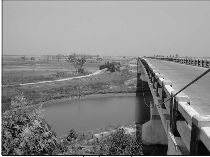
कटौझा में पुल निर्माण
